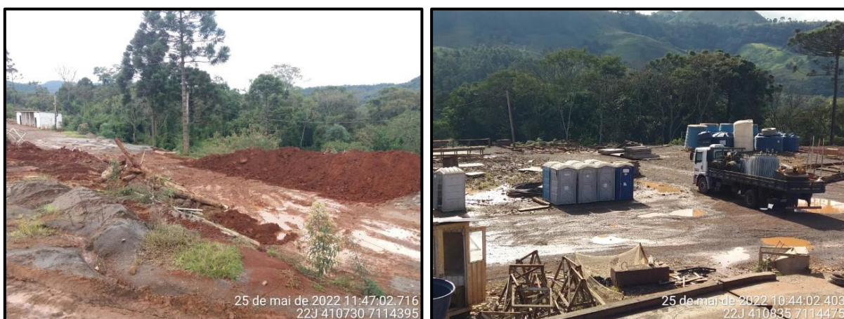
Figura 28 – Desmobilização de estruturas temporárias de geração de efluentes (bate-lastro, banheiros químicos).
