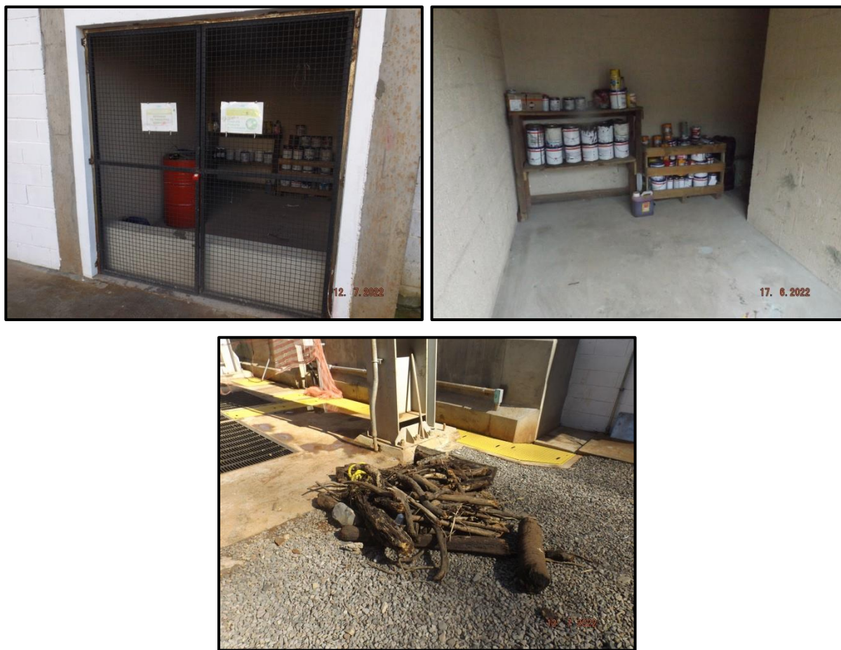
Figura 18 – Registro fotográfico de inspeções relacionadas a resíduos sólidos e produtos perigosos na fase de operação (armazenamento de produtos perigosos e retirada de material do gradeamento da tomada d'água).
