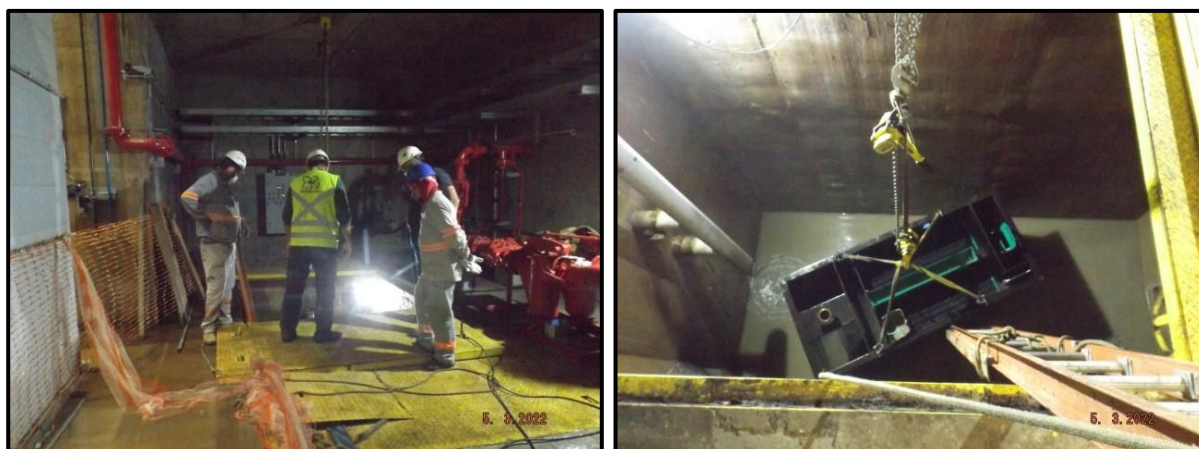
Figura 111 – Instalação de caixa SAO no poço de drenagem da casa de força.
