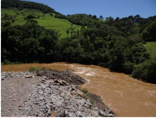
Foto 5.1. Vista geral próximo a casa de força.
