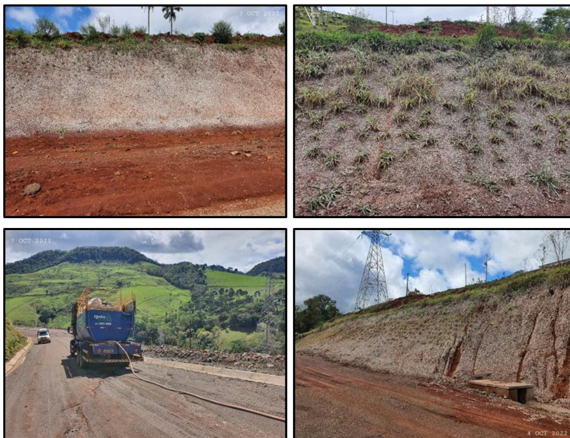
Figura 121 – Hidrossemeadura nos taludes durante os meses de setembro e outubro de 2022.
