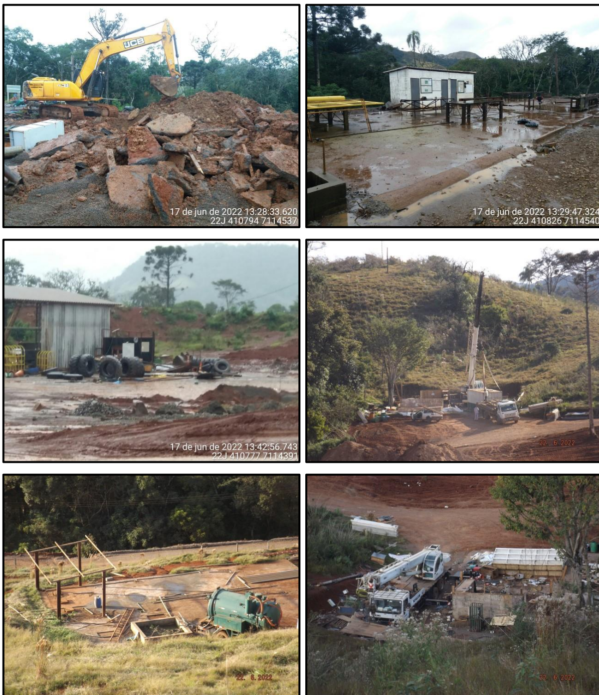
Figura 48 – Registro da desmobilização de estruturas temporárias do canteiro de obras no mês de junho de 2022.
