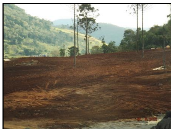
Figura 36 - PM-11 - Canteiro industrial - Suavização de declividade, retaludamento e fechamento de pontos com erosão.
