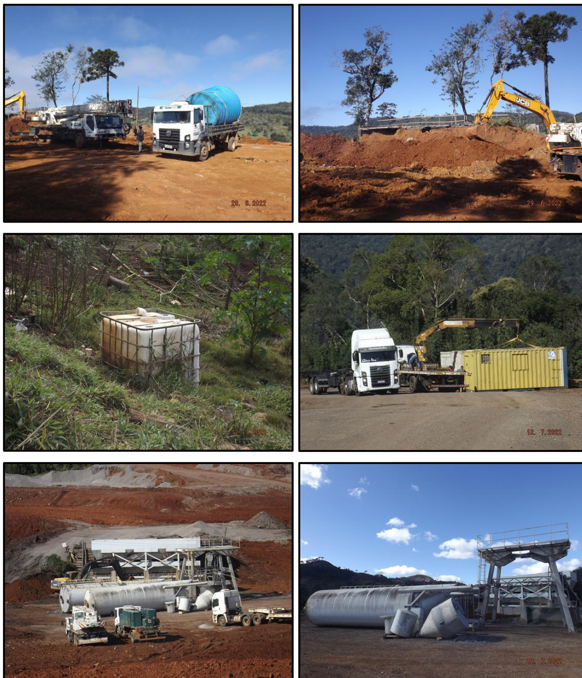
Figura 49 – Registro da desmobilização de estruturas temporárias do canteiro de obras ao longo do mês de julho de 2022.
