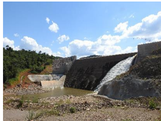
Foto 5.6. Vista geral da base do barramento.
