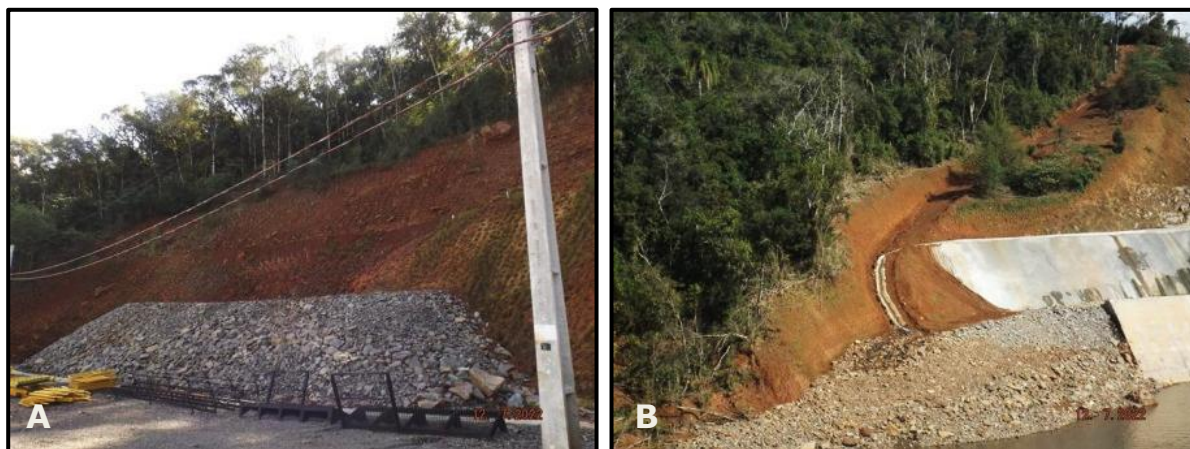
Figura 37 - Proteção com enrocamento na base de talude.
