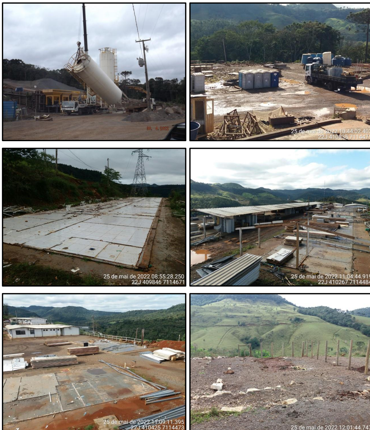
Figura 47 – Registro da desmobilização de estruturas temporárias do canteiro de obras no mês de maio de 2022.
