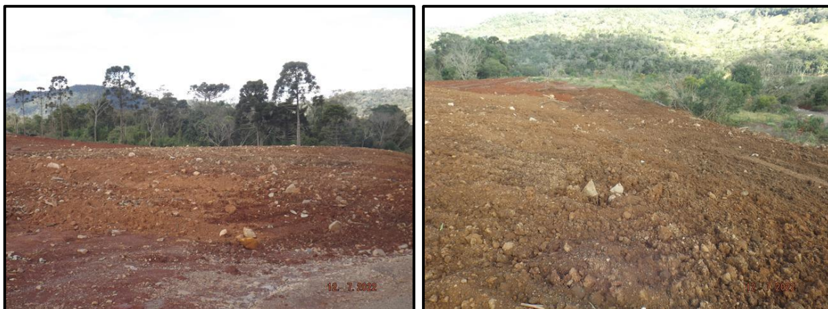
Figura 19 – Desmobilização de central de produtos perigosos.
